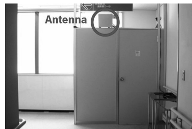
図 7 アンテナ設置状況(a)
