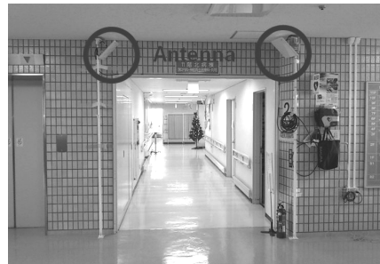
図10 アンテナ設置状況(b)
